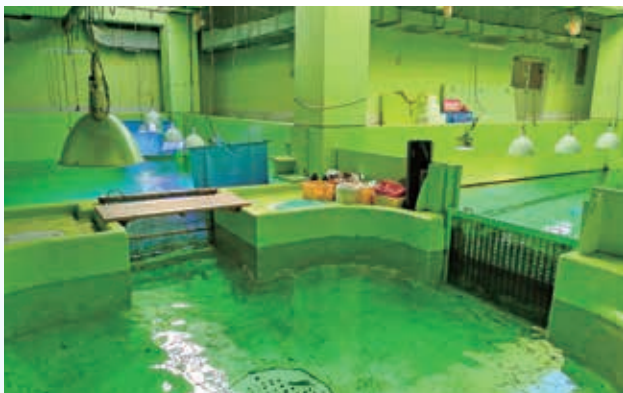
バックヤードの予備水槽（ここを通って右側の展示水槽へ移動します）
