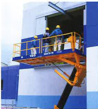
高所作業車でセレナの入ったコンテナは慎重に3階まで上げられる。セレナは、荷台の箱の中に収められている。
