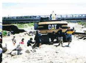
工事現場（なんの工事？）
