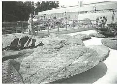
新鳥羽水族館建設中のサンゴや擬岩の取り付けの様子
